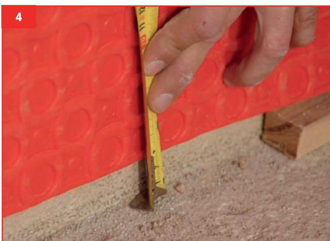
**4. IMPORTANTE:** Lasciare uno spazio nella parte inferiore e superiore di 1-3 cm per il ricambio dell'aria.
