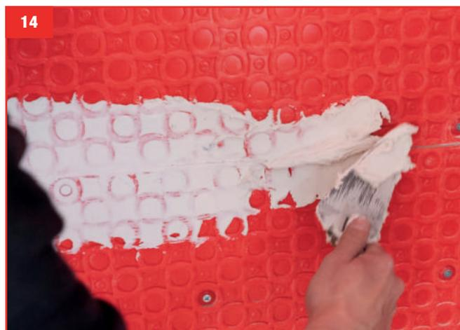
**14.** Per installare la bandella W-S BAND 14, riempiamo prima tutti i noduli con colla cementizia tipo C2 o monocomponente tipo EASEAL e poi utilizzeremo la spatola dentata per appiattire (pettinare) il materiale.
