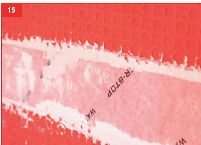
**15.** Infine incolleremo il W-S-BAND 14, tensionandolo ed eliminando il materiale in eccesso con la parte piatta della spatola dentata.
